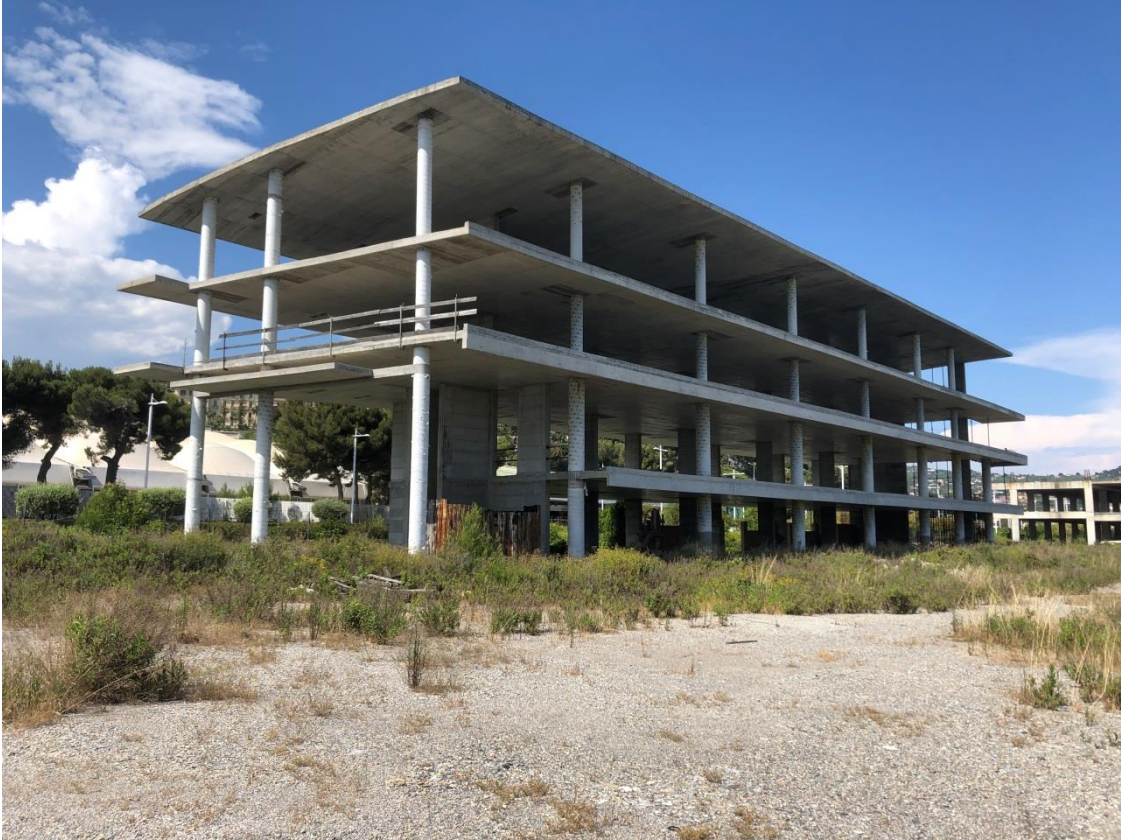
Fabbricato C: struttura
